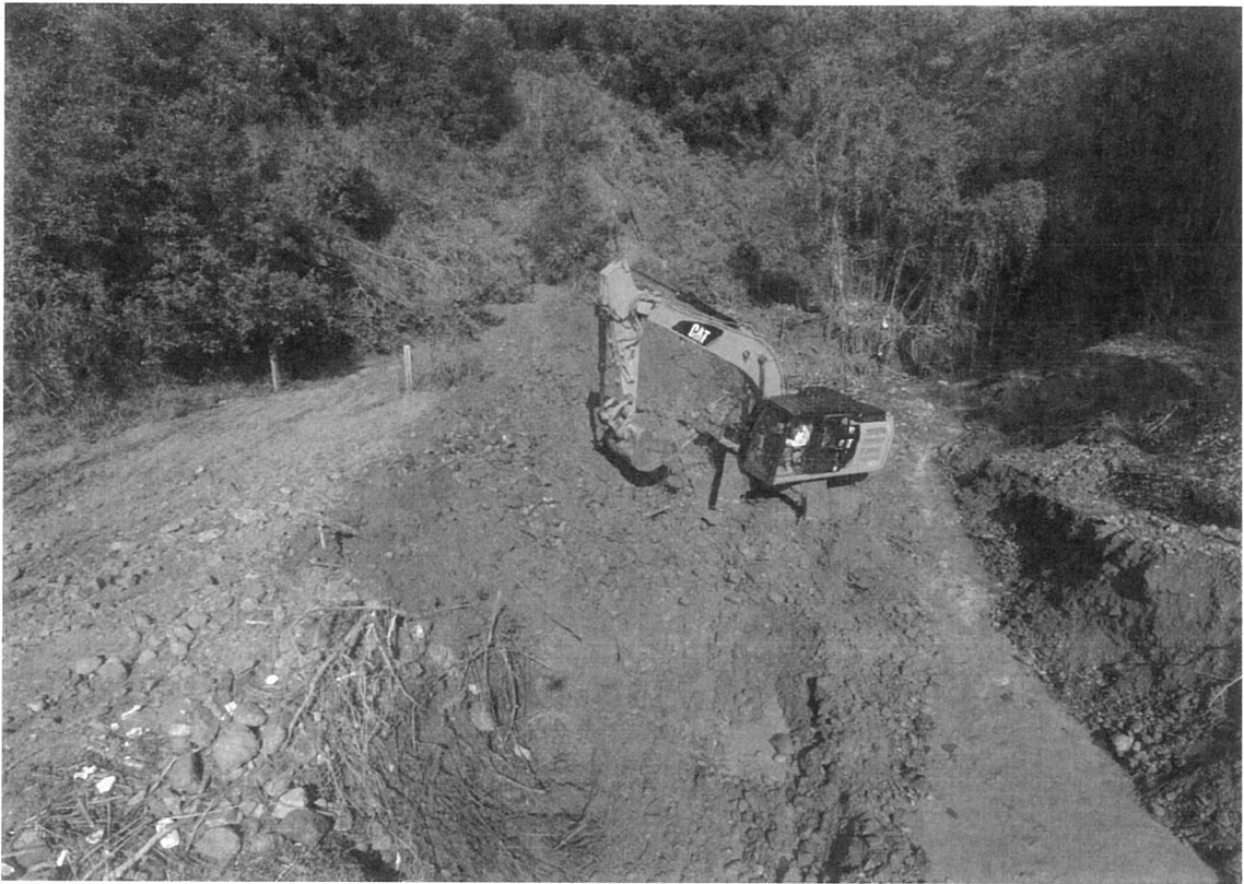
Ripristino officiosità idraulica Torrente Turrina in Loc. Agrosini
