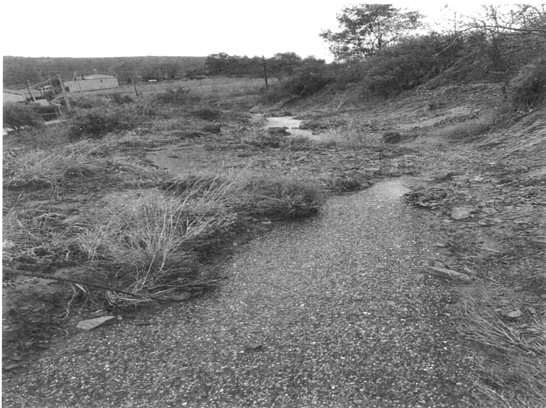
Frane e smottamenti in Loc. San Salvatore
