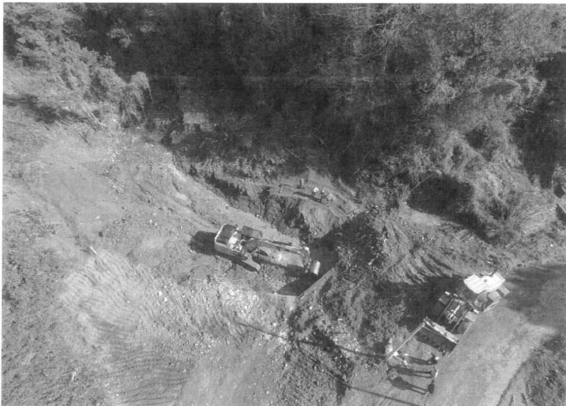
Attraversamento torrente Turrina sulla strada per Agrosini
