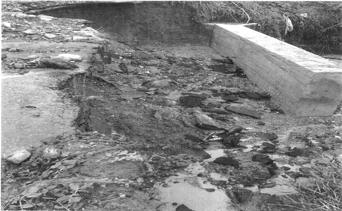
Attraversamento Torrente turrina in loc. Agrosini
