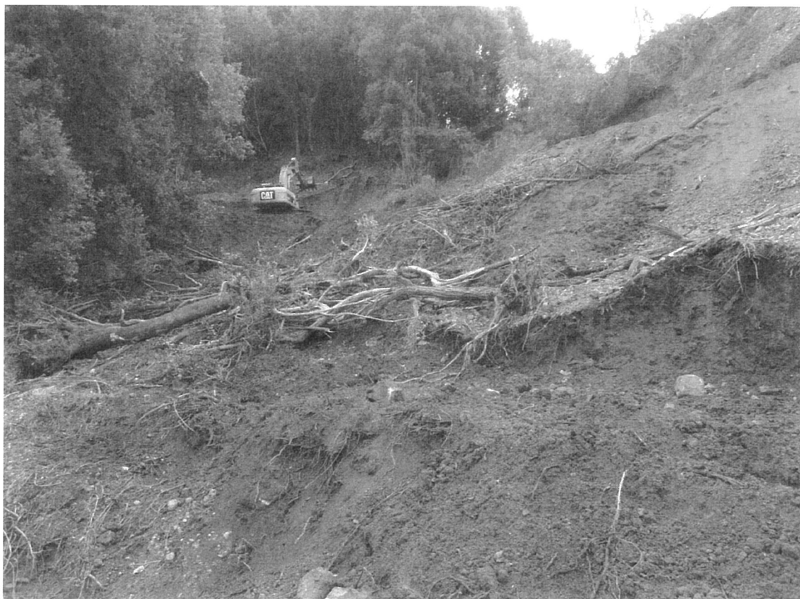
Messa in sicurezza frana in Loc Agrosini
